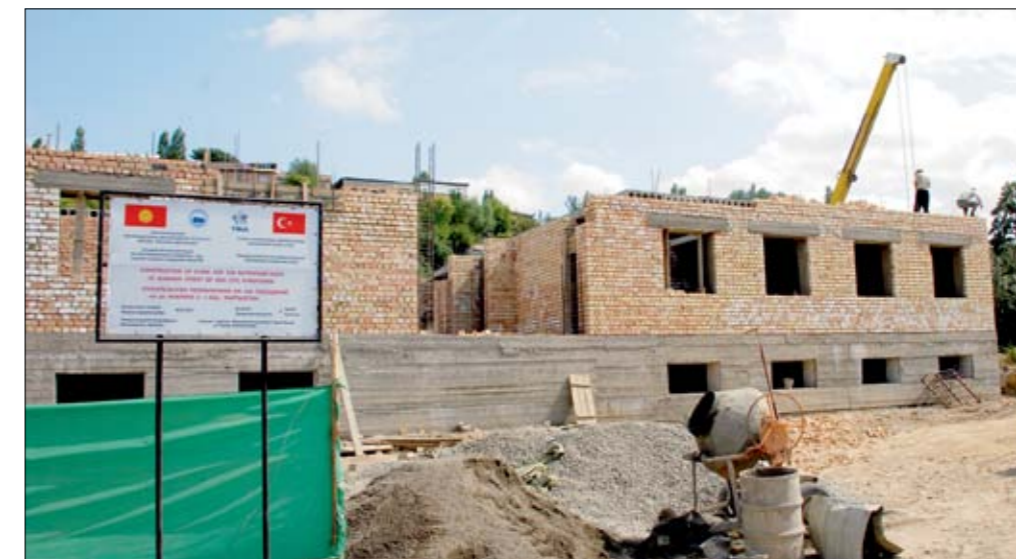
Эта больница в Оше строится Госдирекцией при поддержке ТИКА. This hospital in Osh is being built by the State Directorate with the support of TICA.
